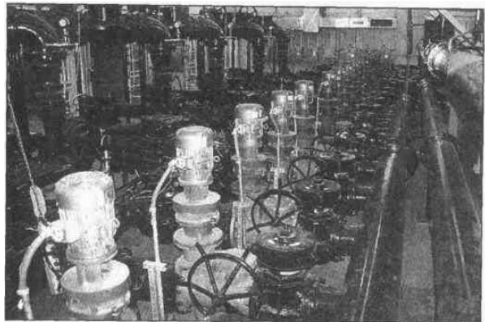
Figura 3. Vista lateral e instalación típica de molinos de lodos (Metcalf & Eddy, Inc., 2003)
