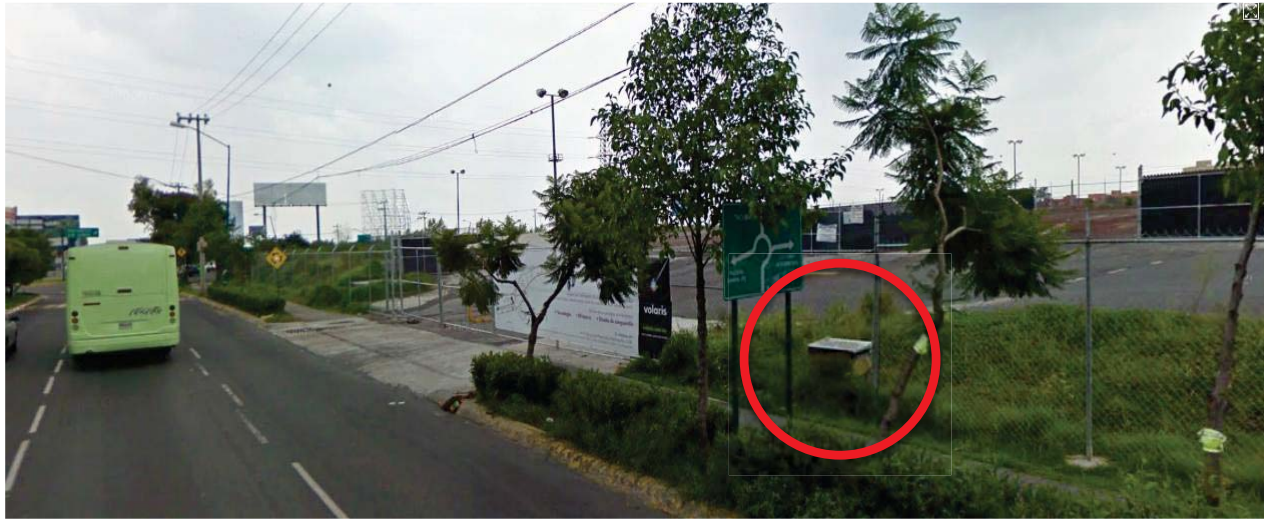
Ubicación transformador CFE
