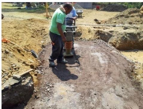
Fig. 6.5 Compactación Manual de Balastre.
