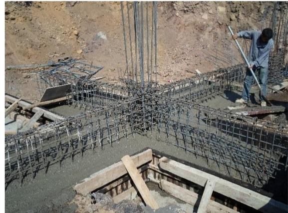
Fig. 6.11, 6.12 “Colado de cimentación de zapatas corridas”
