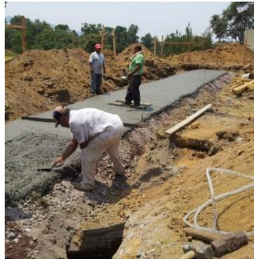
Fig. 6.6 Colado de Plantillas de Concreto.
