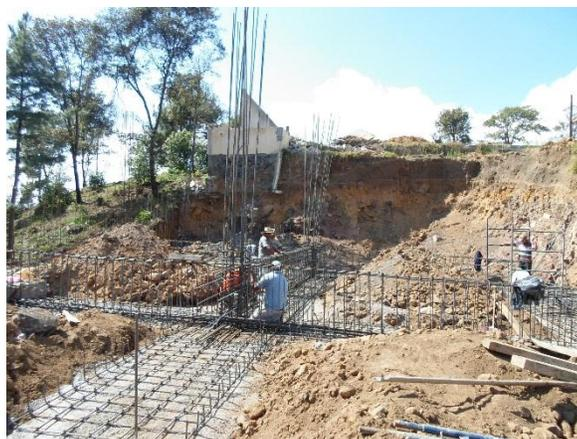
Fig. 6.9 “Zapata Corrida con Contra Trabes”
