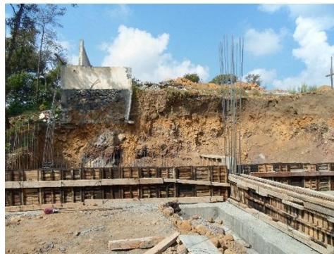
Fig. 6.10 “Cimbra de cimentación de zapata corrida con contra trabe”
