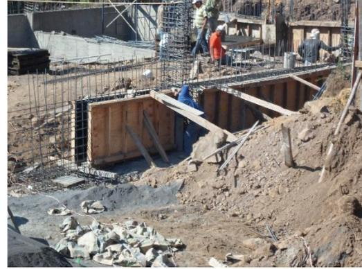
Fig. 6.14 “Armado de Muro de Contención”
