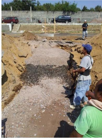
Fig.6.4 Colocación de Filtro y Base.
