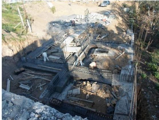
Fig. 6.13 “Cimentación de Zapatas corridas descimbrada”
