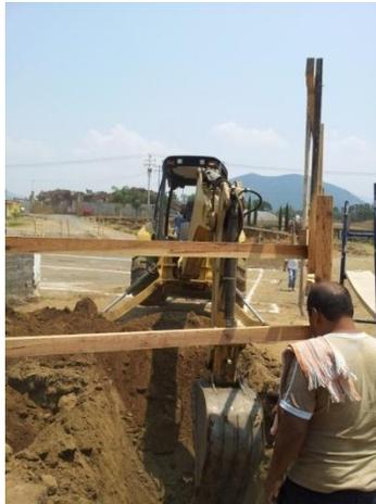
Fig. 6.3 Retroexcavadora realizando cepas.
