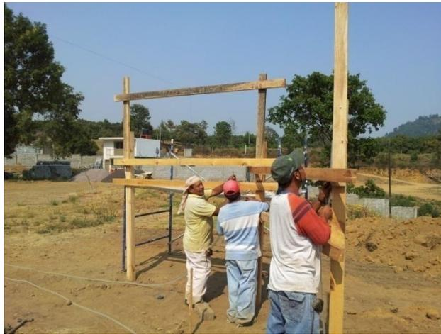
Fig. 6.1 Elaboración de Crucetas para ejes de referencia.
