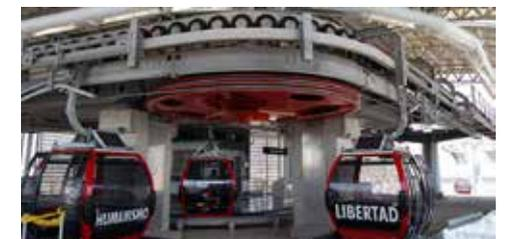
Maquinaria y Poleas que impulsan el sistema de Metrocable, giro de vía a 90°.
