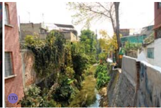
Viviendas construidas junto a canal de agua en Centro Histórico de Xochimilco
