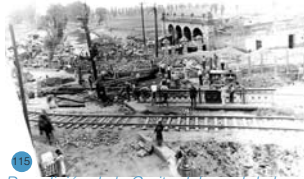
115 Demolición de la Garita del canal de la Viga año 1940
