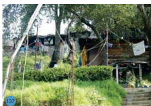
Vivienda en asentamiento irregular
