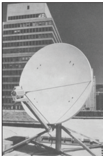
Fig. 2-3. ODU para una estación VSAT. [2]
