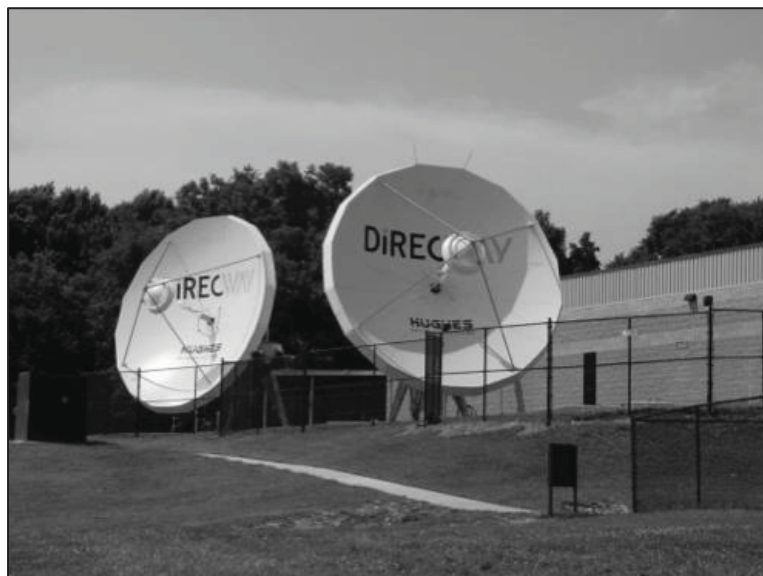
Fig. 2-7. ODU de una estación HUB. [2]
