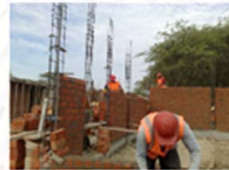
Arma de castillos y traves sistema tradicional
