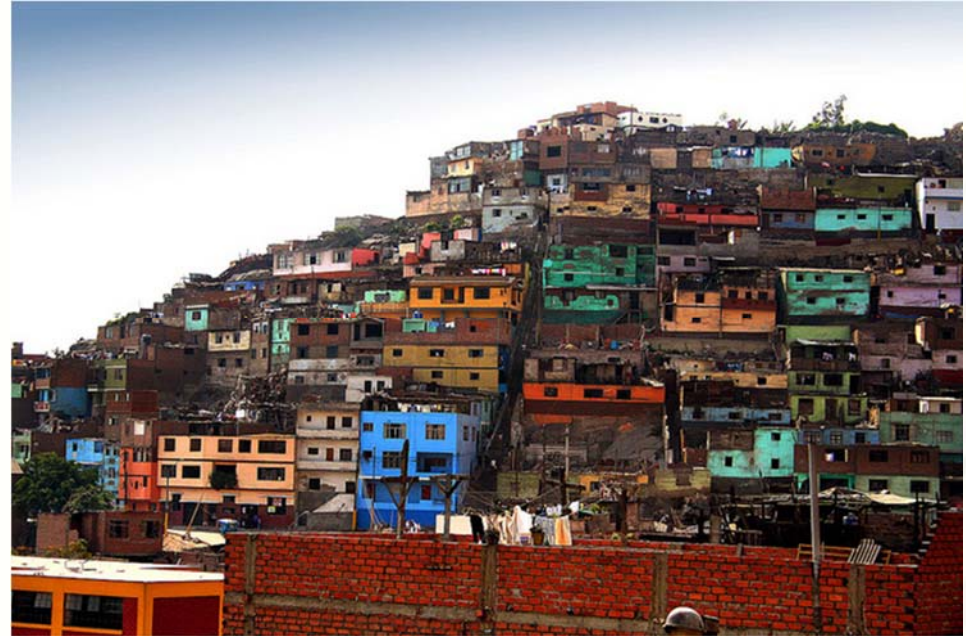
Vivienda en terrenos no aptos
