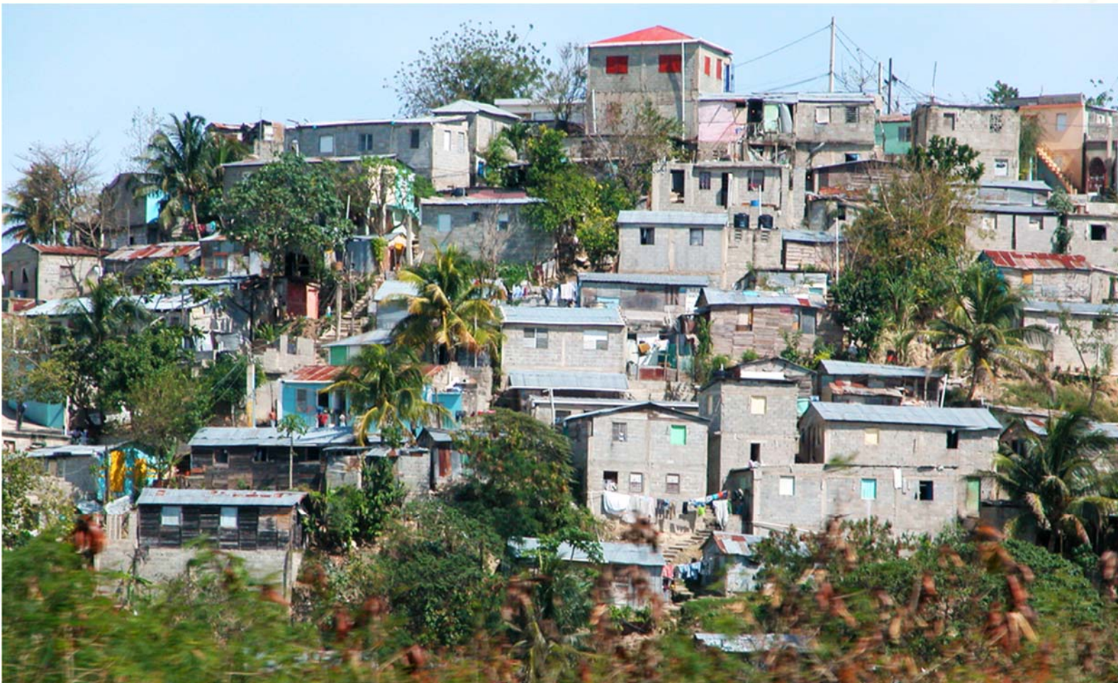
Vivienda en terrenos no aptos
