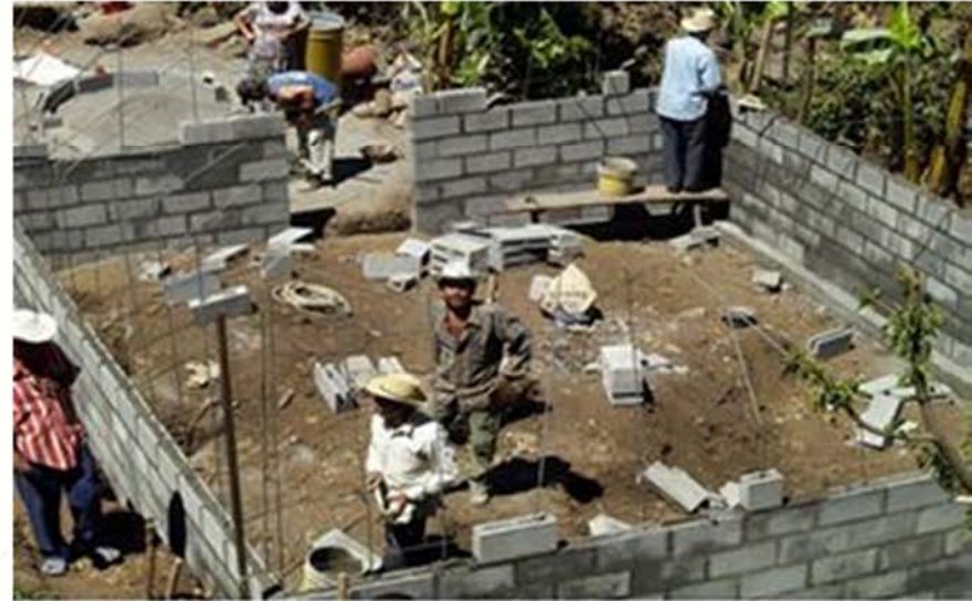
Foto de vivienda de autoconstrucción
