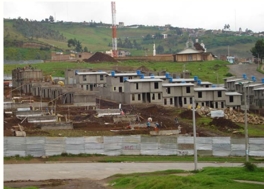
Construcción de viviendas en condominio
