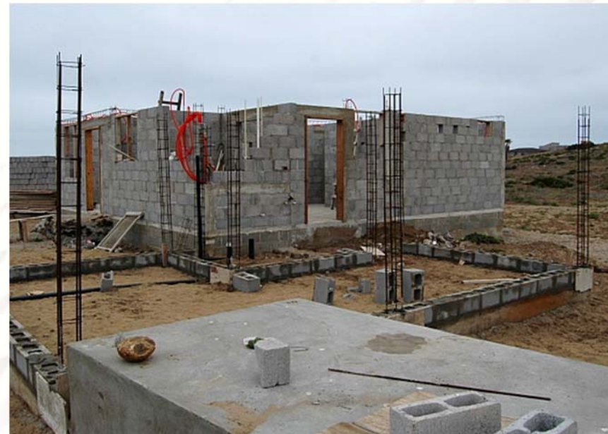
Construcción con sistema tradicional de muros de tabique
