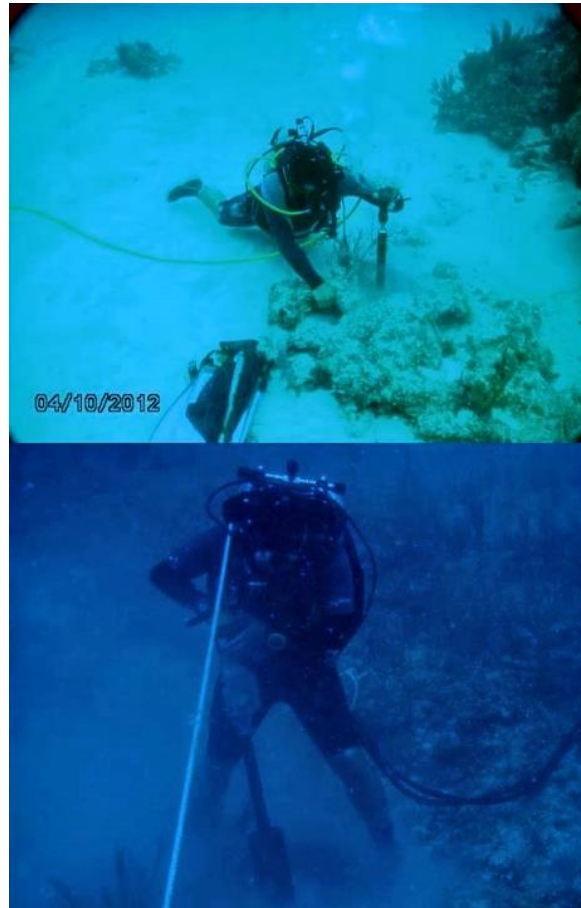
Figura 6. Perforación con taladro de aire comprimido (arriba) y taladro hidráulico con compresora dentro de borda (abajo).
