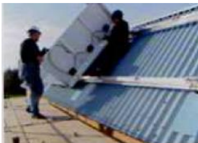
Fig.5.15 Ejemplo de montaje y paneles fotovoltaicos en una cubierta inclinada.
