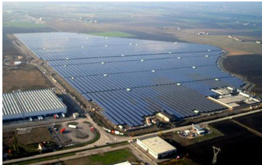
Fig. 3.32 Central solar fotovoltaica. 16
