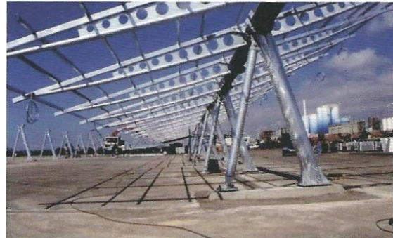
Fig. 5.6 Montaje, utilizando una grúa, de la parte superior de la estructura (izquierda). Aspecto de la estructura una vez terminada (derecha).
