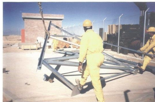
Fig. 5.5 Traslado de parte de una estructura hasta el lugar en que va a ser instalada.
