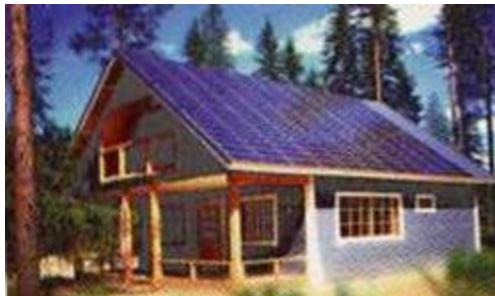
Fig.5.2 estos módulos de silicio amargo descansan directamente sobre el tejado, no siendo preciso construir una estructura. 1
