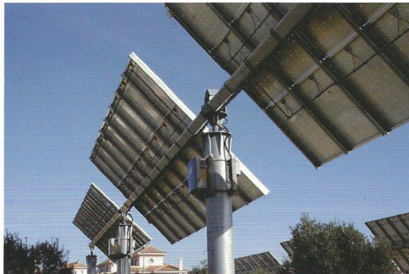
Fig. 3.22 Rotación de paneles alrededor de un eje inclinado con un ángulo igual a la latitud y orientado paralelamente al eje terrestre (eje polar).
