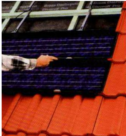
Fig.5.14 Modulo específicamente diseñado para sustituir a las tejas convencionales.
