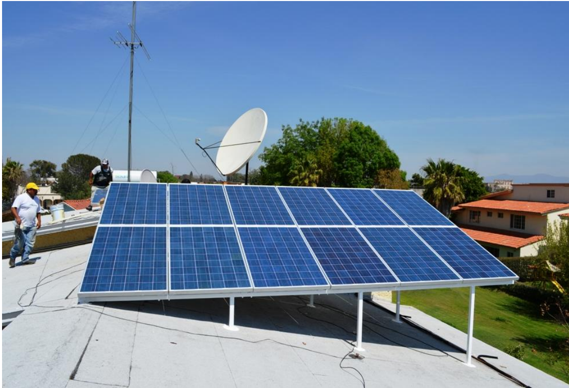
Fig. 3.6 Los módulos se comercializan habitualmente con un marco que permite su montaje sobre las superficies y estructuras más comunes (paredes, perfiles metálicos, etc.). 4
