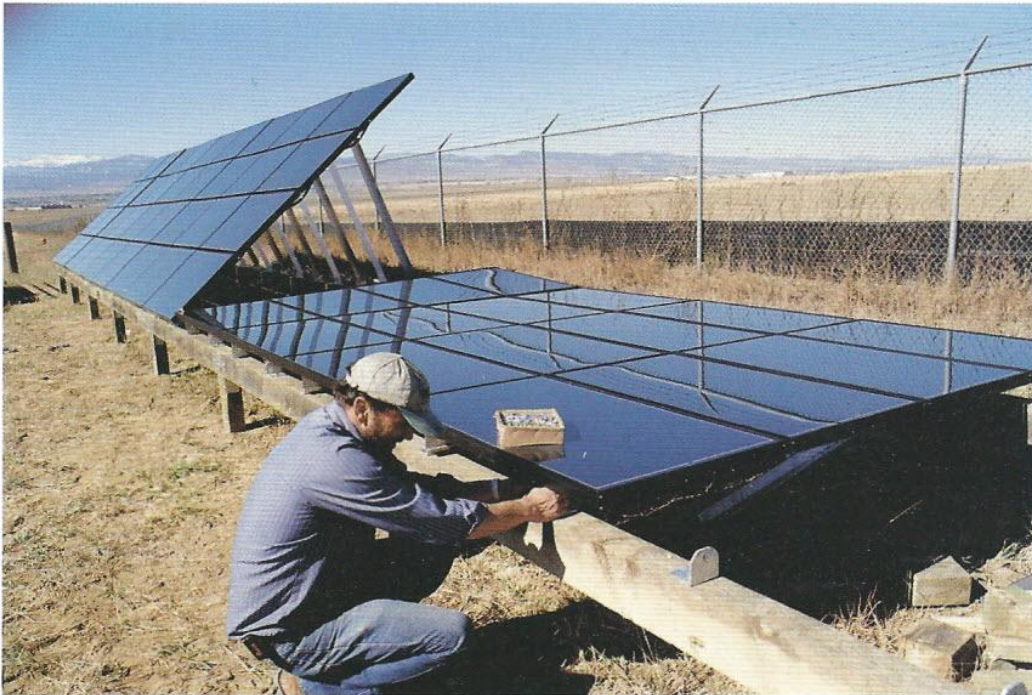
Fig. 5.16 Proceso final del montaje de los paneles pre-ensamblados en la estructura de la figura 27. Los paneles se disponen horizontalmente, como se observa en la fotografía, el operario asegura las uniones en la parte frontal, y posteriormente se levantan, terminando por atornillar las patas a las piezas metálicas del rastrel posterior.
