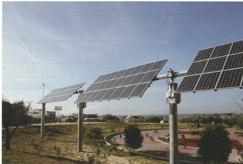
Fig. 3.21 En este seguidor el eje transversal está orientado en la dirección norte-sur, y por tanto, los paneles giran de este a oeste.
