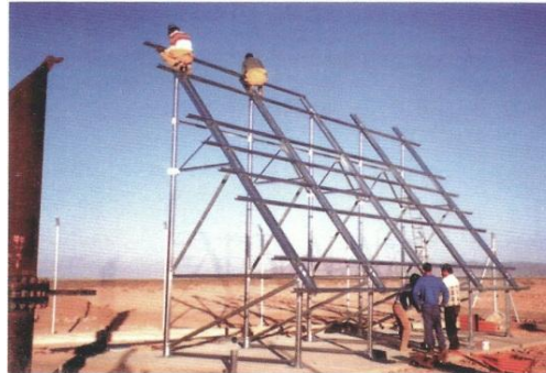
Fig. 5.12 En las estructuras de mayor tamaño, el montaje es una tarea que comporta riesgo, y no puede dejarse en manos de operarios inexpertos.
