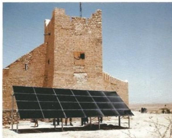
Fig. 5.1 Muestra del fuerte contraste entre el campo de paneles fotovoltaicos y un entorno extraño a los mismos.
