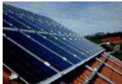
Fig.5.15 Ejemplo de montaje y paneles fotovoltaicos en una cubierta inclinada.
