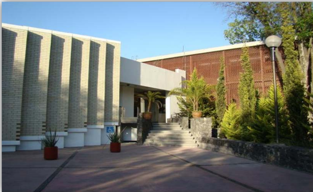
Figura 11. Instituto de Ingeniería, Edificio 1.
