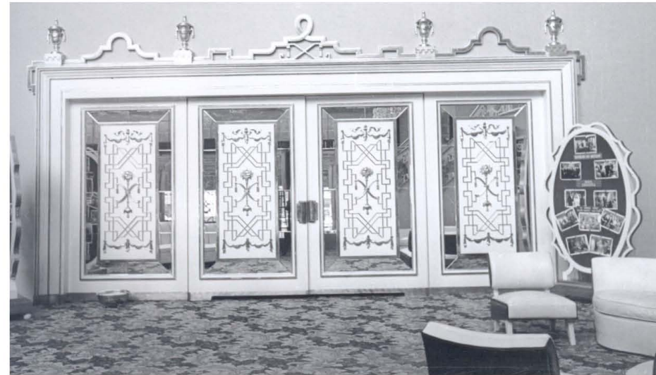
Foto: 3.15 Detalle de las puertas de acceso al lunetario
