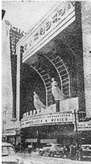
Foto: 3.7 Fachada C.
