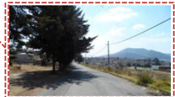
Vialidad oriente central, vista sur
