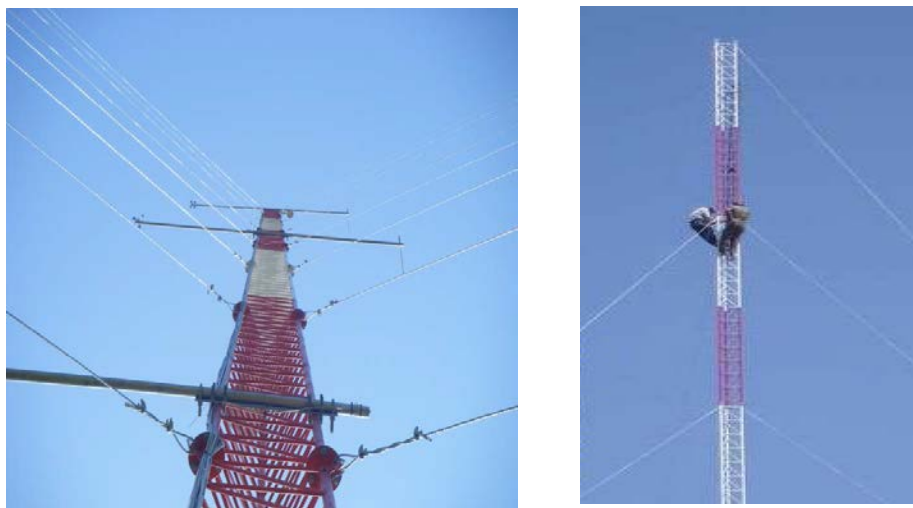
Figura 1.2 Torres arriostradas o atirantadas
