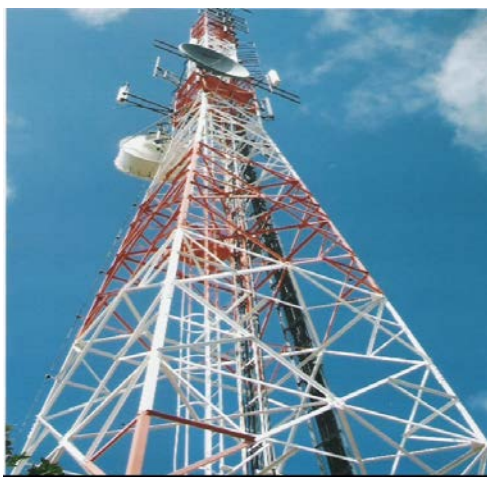
Figura 1.3 Torre autoportada
