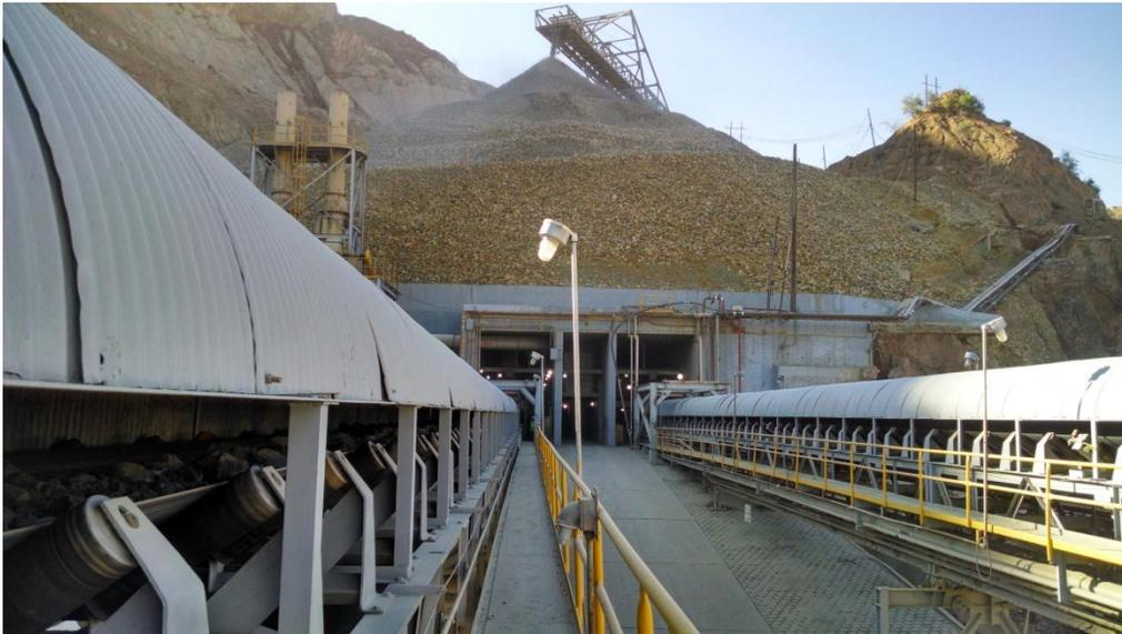
FIG. 2.40 Bandas 3a y 3b con mineral del almacén de gruesos a planta de trituración fina
