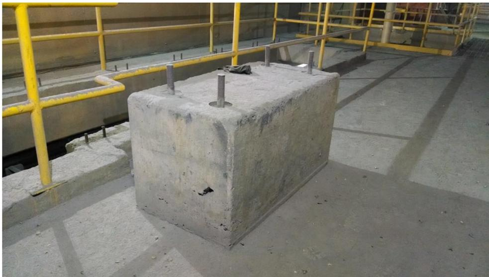
FIG. 2.7 Espacio para colocar motor del alimentador en lado A
