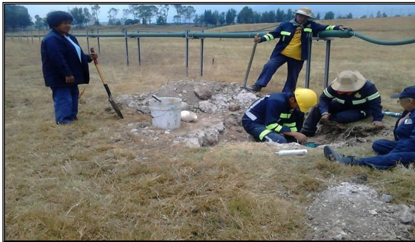
Figura. 17. Mantenimiento a la red de extracción de biogás en Prados de la Montaña.
