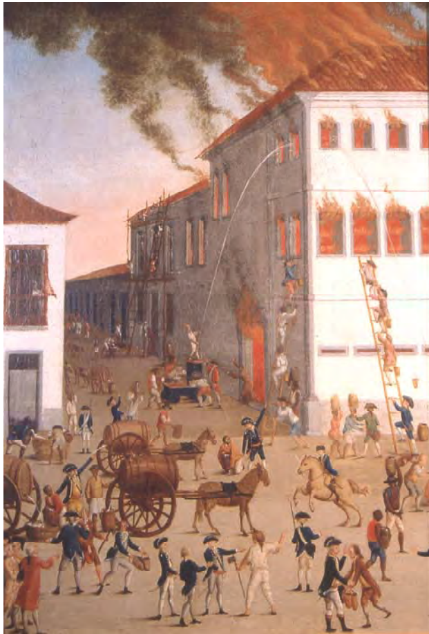
Detalle de la bomba
