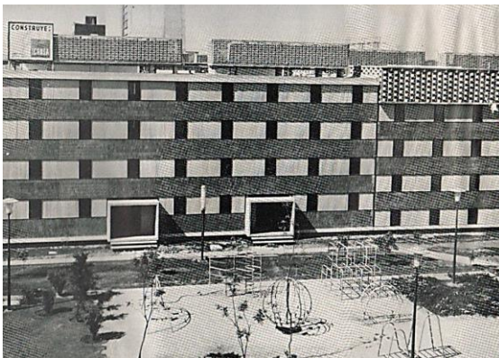
Edificio tipo “A”, 1966
