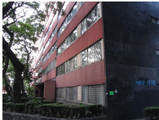
Edificio tipo “A”, 2014
