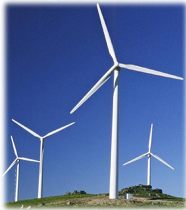
**Figura 7. Aerogenerador tripala de eje horizontal. Fuente: [www.amdee.org](http://www.amdee.org)**
