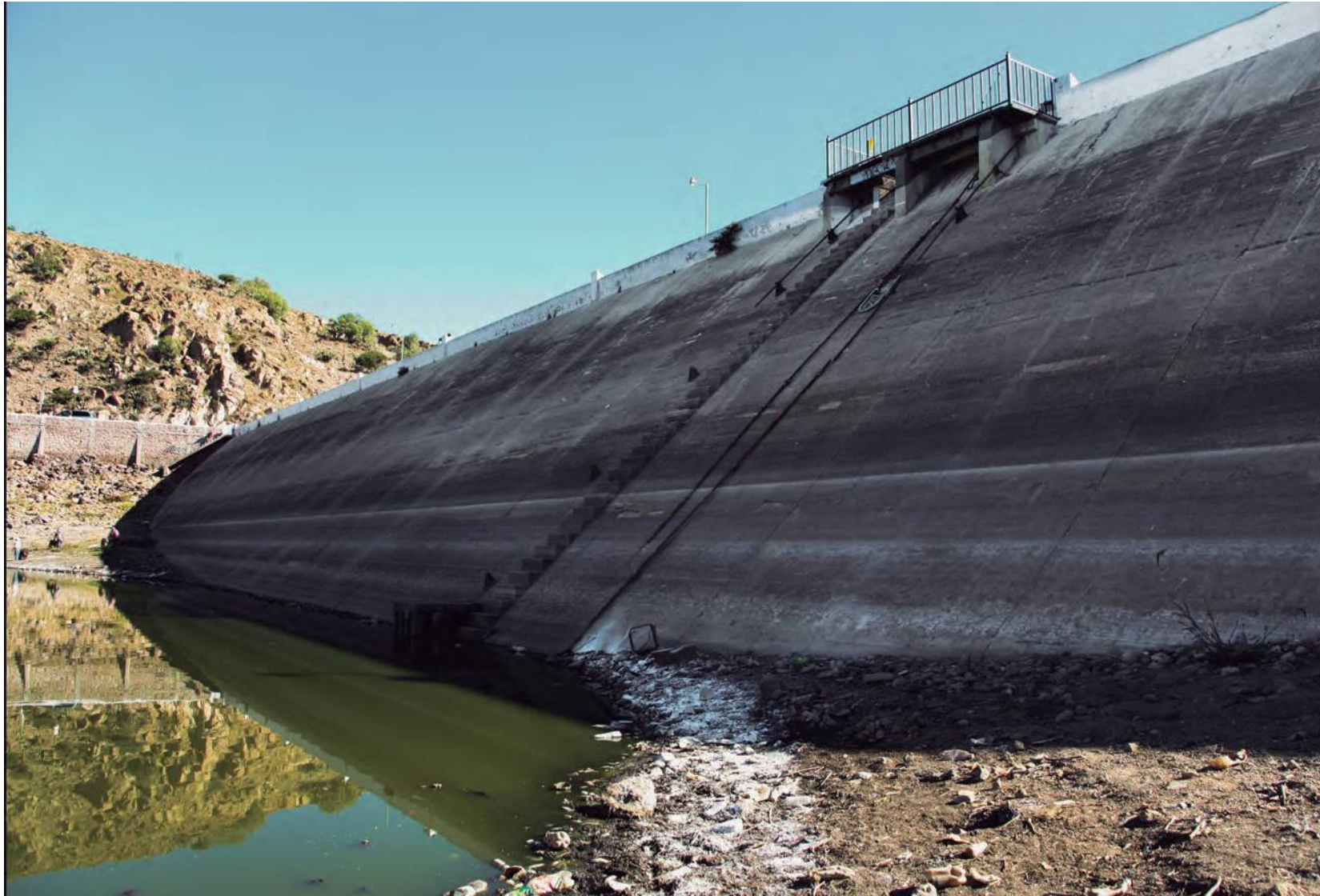
Fotografía 26. Presa de Mexquitic de Carmona, S.L.P. Fotografía Elizabeth Flores López. Noviembre 2012
