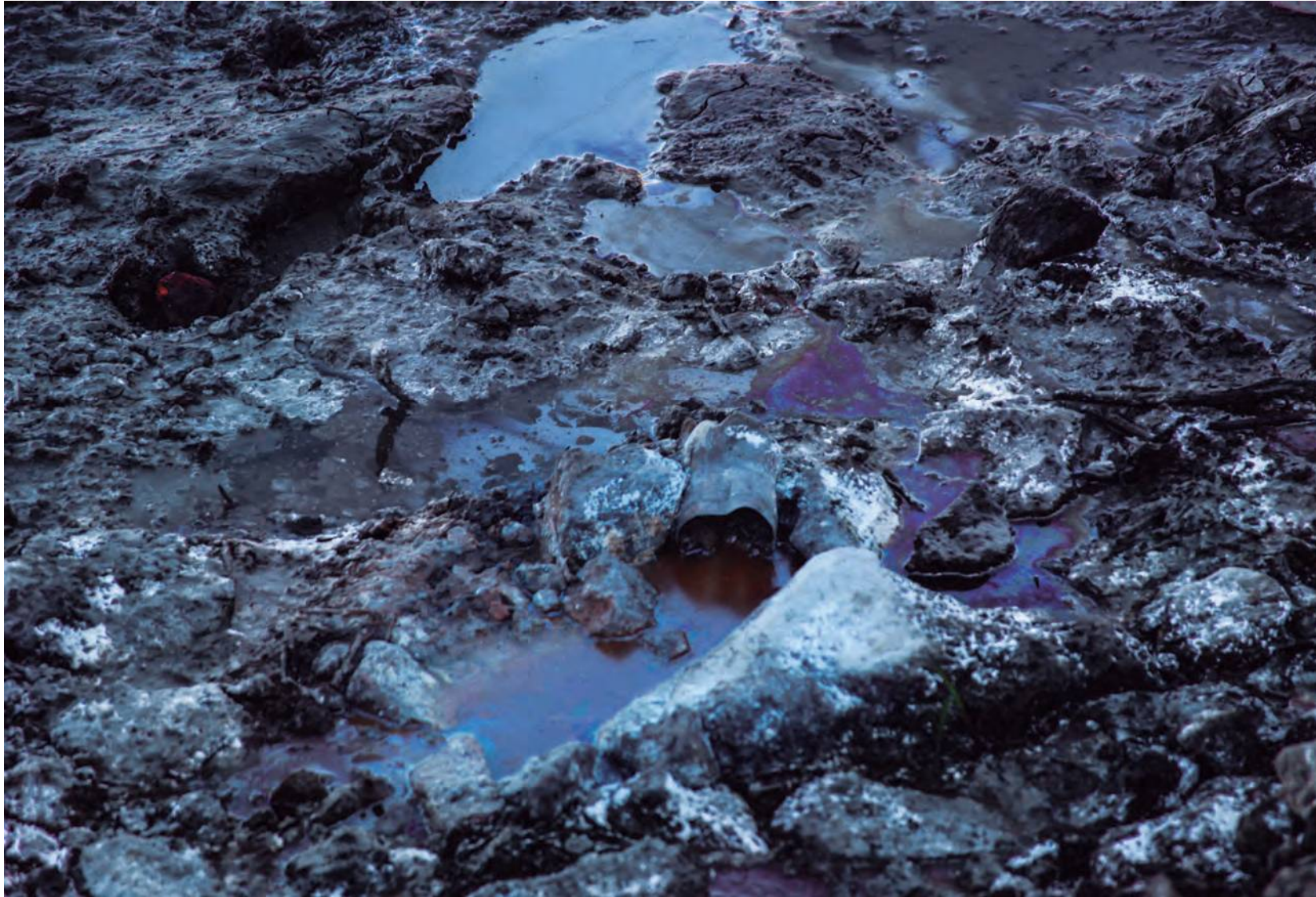
Fotografía 28. Presa de Mexquitic de Carmona, S.L.P. Fotografía Elizabeth Flores López. Noviembre 2012
