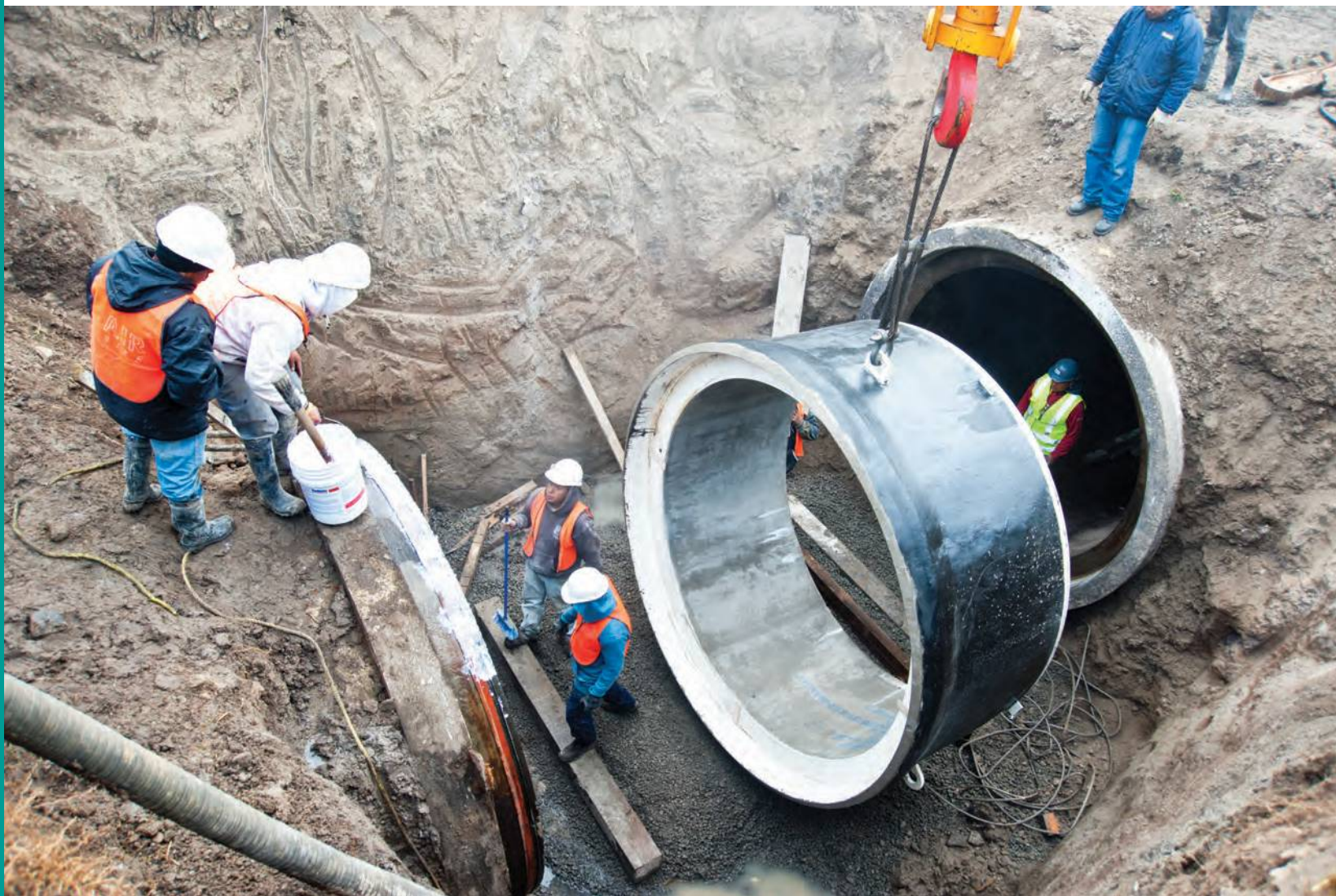
Fotografía 22. Sistema Cutzamala. Fotografía Carlos Contreras de Oteyza
