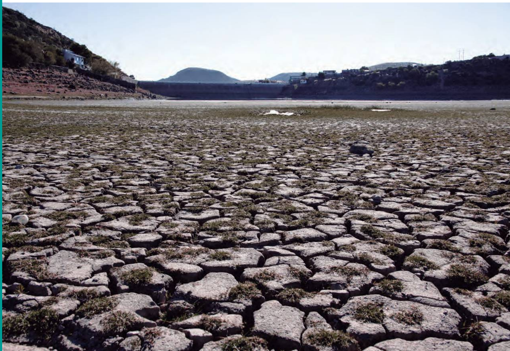
Fotografía 25. Presa de Mexquitic de Carmona, S.L.P. Fotografía Elizabeth Flores López. Noviembre 2012
