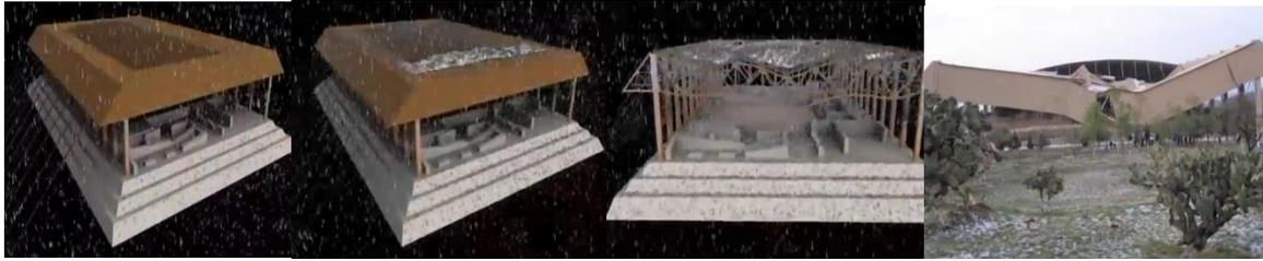
FUENTE: Modelado INAH Estructura del Gran Basamento del colapso de la Techumbre.
