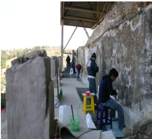
Dicha deformación consiste en una inclinación importante a causa de la carga que soporta en la parte superior, donde se encuentra un relleno que, originalmente era soportado por un talud. Al perder dicho talud su altura original, el relleno quedó expuesto a la intemperie, especialmente severa en este punto del basamento.
