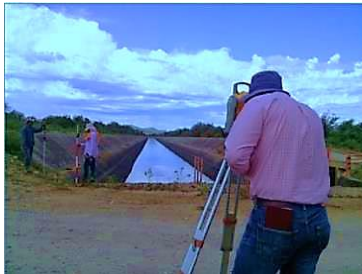
Fotografía 6.5. Levantamiento en planta del canal e infraestructura.
