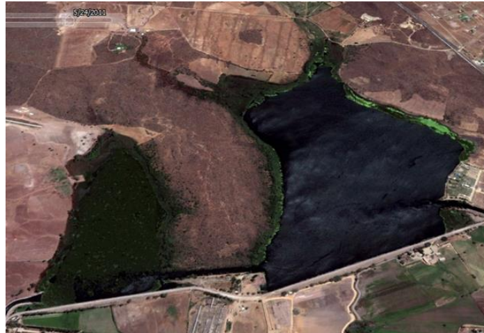
Ilustración 1.1. Diques Batamote y Arroyo Prieto.
