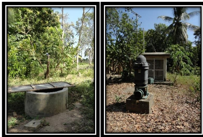
Fig. 50. Pozo artesanal y pozo profundo de puyón (der) en los huertos familiares de V. Mazatán, Chiapas. Fuente: Trabajo de campo (2013-2014).
