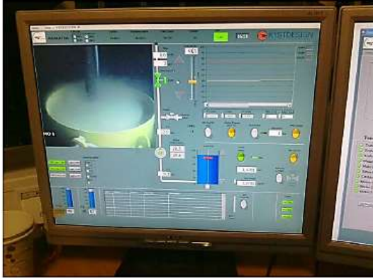
Figura 4. 22 Control del sistema RMR dentro del contenedor. 25
