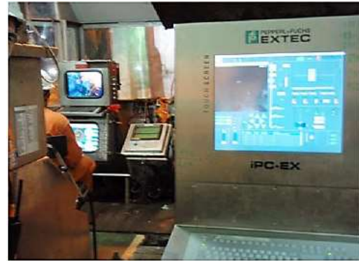
Figura 4. 23 Control del sistema RMR dentro de la cabina del perforador. 25
