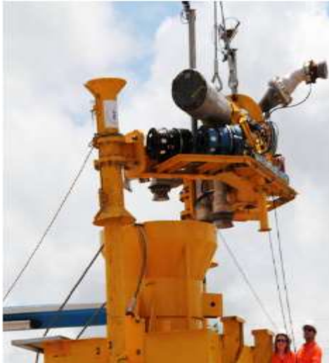
Figura 4. 11 Colocación del sistema de bombas. 25
