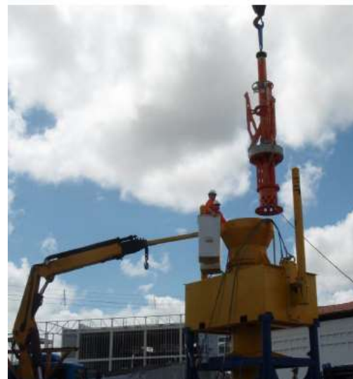
Figura 4. 10 Colocación del sistema de succión. 25
