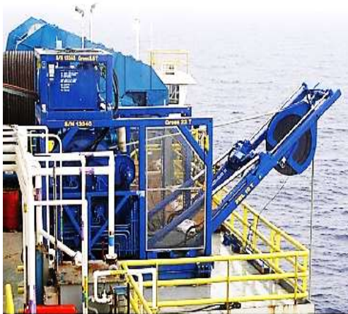
Figura 4. 20 Cabestrante con umbilical colocado en cubierta. 25
