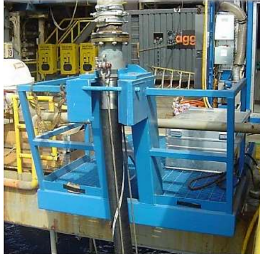
Figura 4. 19 Plataforma de manipulación de la manguera con la línea de retorno del lodo instalado. 25
