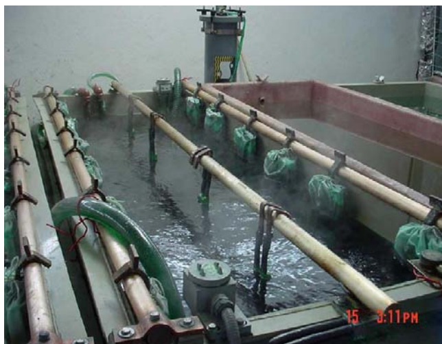
Figura 16. Tanque de baños de Níquel 20
