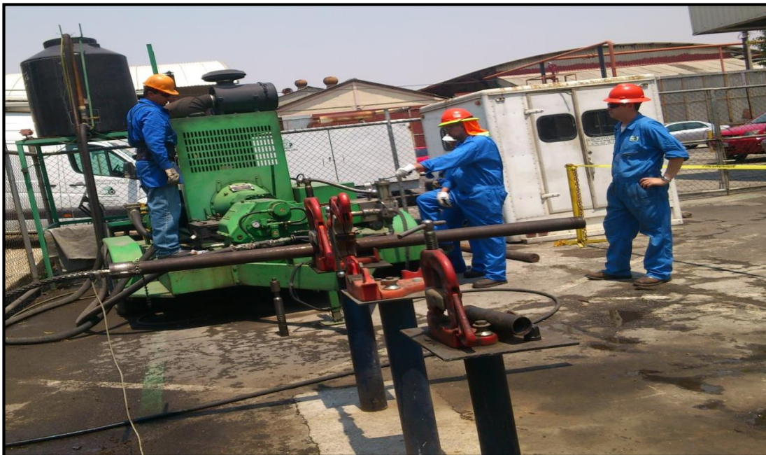
Figura 4.23 Prueba de hermeticidad y anclaje con Bomba de Alta Presión y Sensor de Presión acoplado a la entrada de la TP de 2 7/8".
