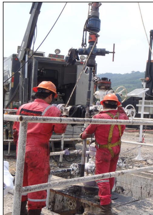
Figura 4.27 Representa el acoplamiento del MPFV a sarta de Línea de Acero.
