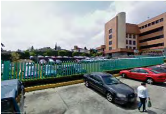
VISTA PRINCIPAL DE CONJUNTO SOBRE CALLE LA TEJA
