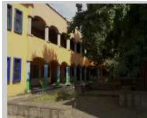
Patio Fachada norte
