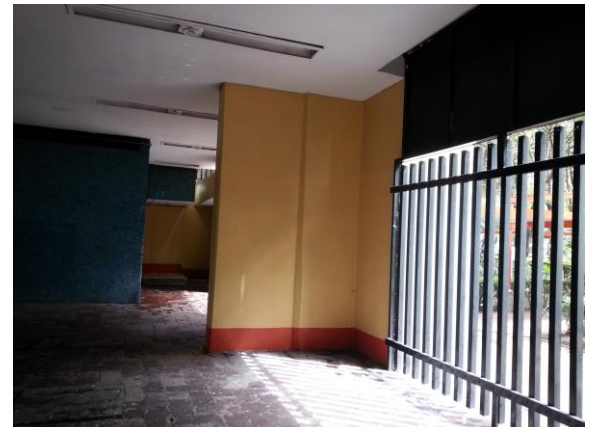
Planta baja del edificio Chihuahua, muestran uno de los módulos de acceso, el cual conserva el piso original de cantera rosa, mármol en los muros del núcleo de elevadores y mosaico veneciano en color azul, éste presenta restauraciones debido a los desprendimientos originados por los temblores. Los muros en color amarillo y ocre son iniciativa de algunos residentes.
