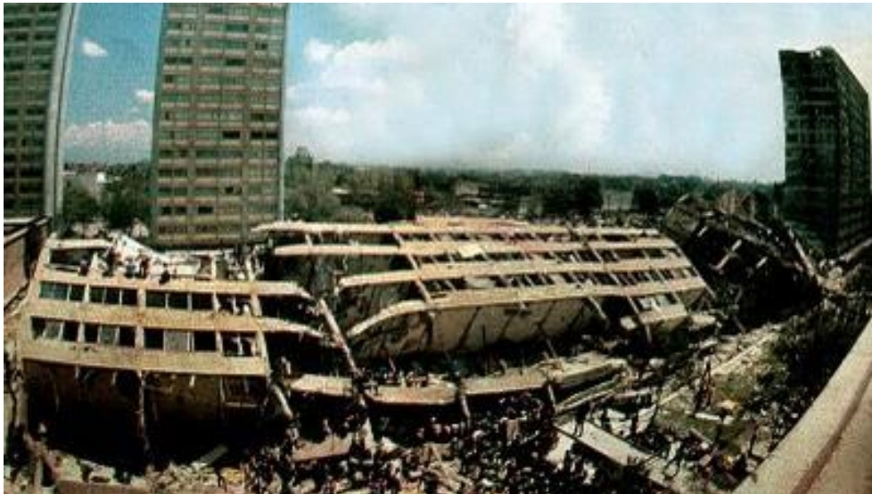
Caída del Edificio Nuevo León.
