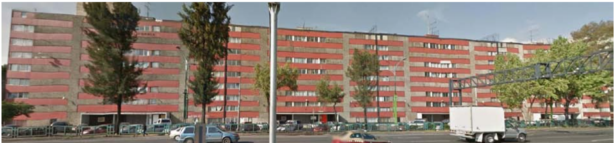
Fachada del edificio Baja California tipo “Bp”.
