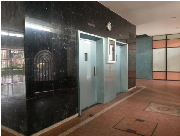
Planta de acceso del edificio Presidente Juárez, módulo AB. Modificaciones en recubrimiento de pisos; el resto de los acabados corresponde al proyecto original.
