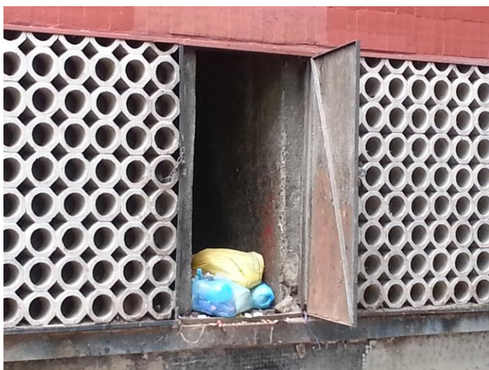
FUENTE: Recorrido de campo. Ducto de basura en fachada principal del edificio Sonora
