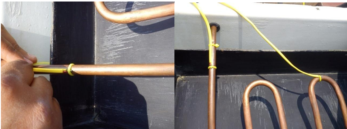
Figura 3.30. Fijación de los termopares del serpentín
