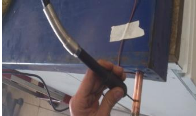
Figura 3.11. Perforación de los calentadores con ayuda del mototool
