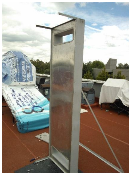
Figura 3.6. Muro solar terminado
