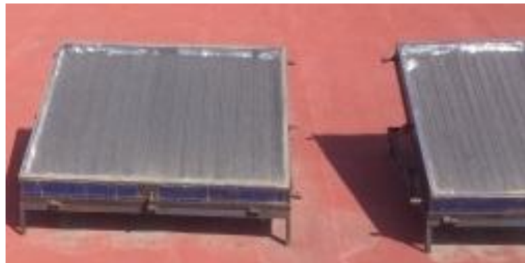
Figura 3.9. Calentadores solares del LIER
