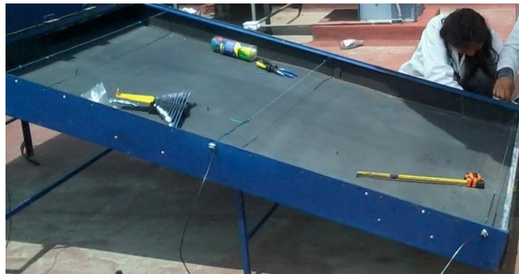
Figura 3.22. Fijación de termopares de la placa colectora del secador solar
