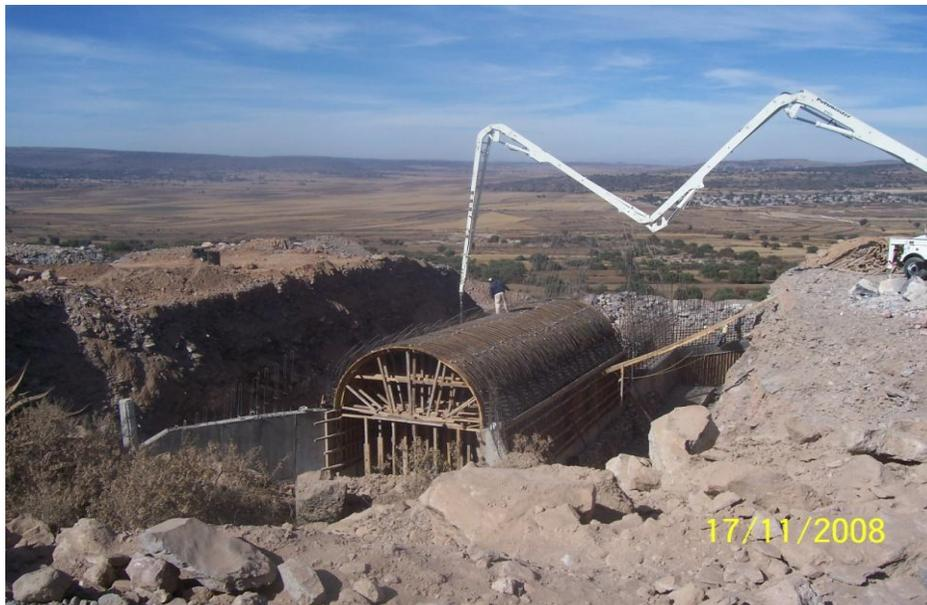
**Img 128.** *Bóveda*: 5.00 m X 4.50 m. Colado de muro 1, trepado 2.
