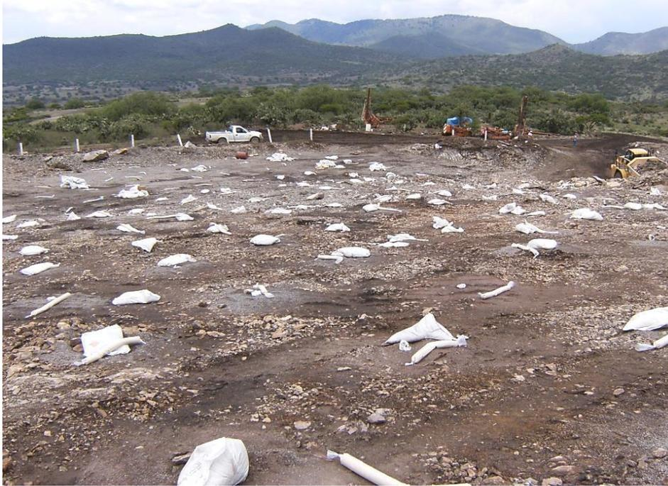
**Img 79.** Explosivos colocados en sus perforaciones para el corte.
