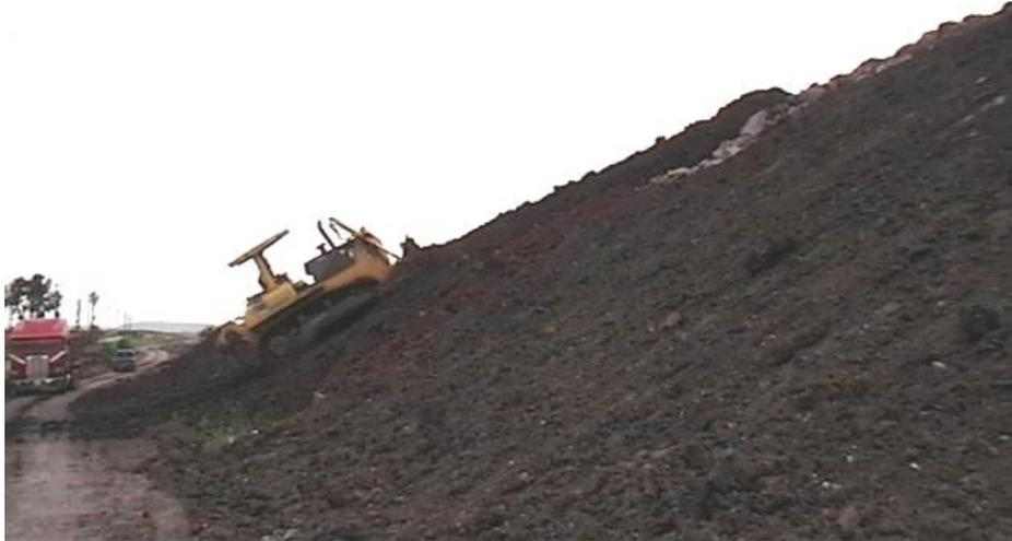
**Img 156.** *Arrope de taludes* con material, producto de despalme. Libramiento Norte de la Ciudad de México, km 24+000. DGDC-SCT.
