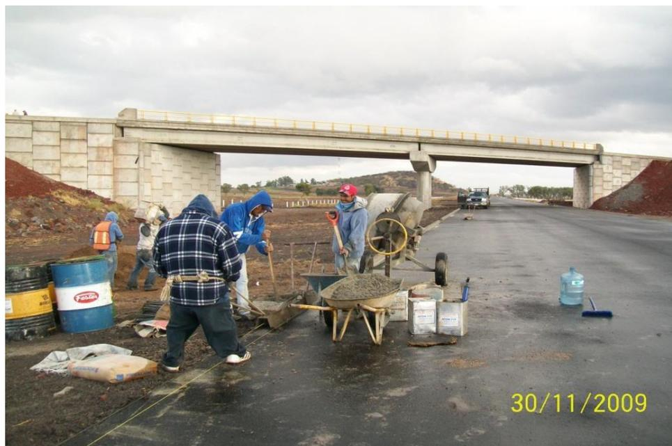
**Img 108.** Colado de *bordillo de concreto hidráulico*.
