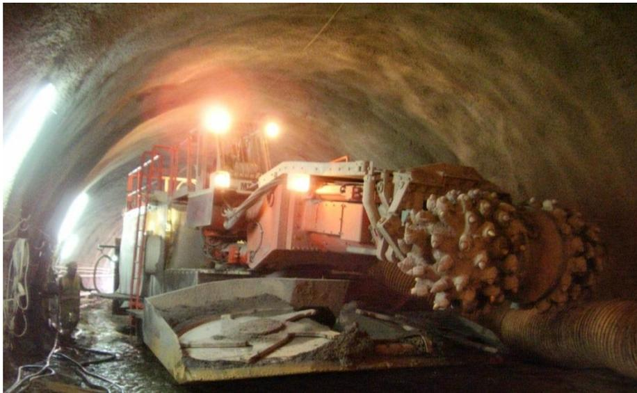
**Img 175.** Máquina excavadora de túneles.
