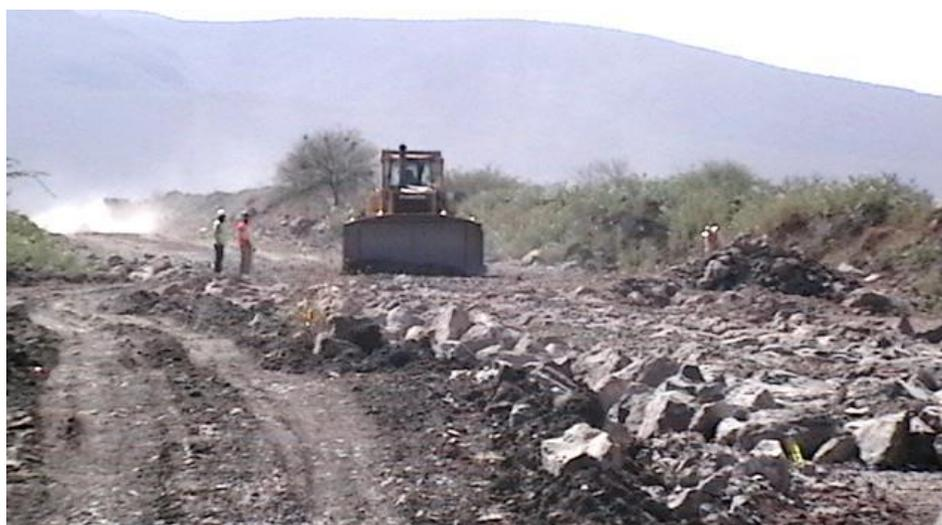
**Img 38.** Formación de terraplén en material “no compactable”.
