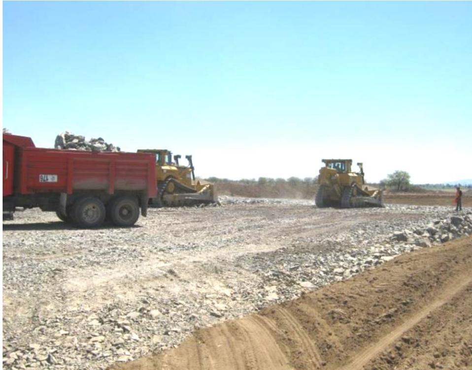
**Img 55.** Terracerías: suministro y tendido de terraplén con material “no compactable”.
