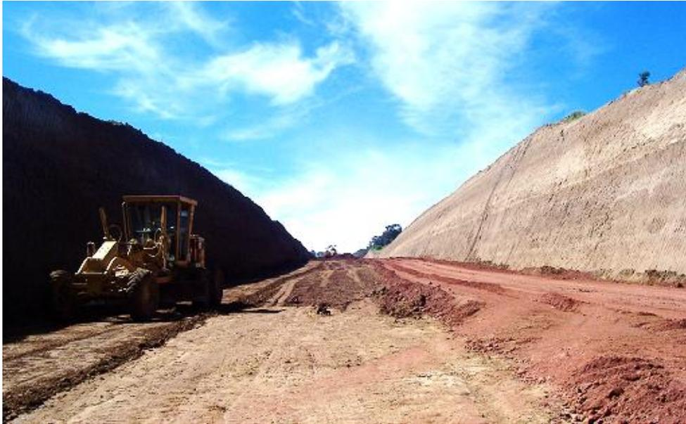
**Img 72.** Vista de corte, en donde se pueden observar dos taludes y la superficie a nivel subrasante. Libramiento Norte de la Ciudad de México, km 106+360 al km 106+740, DGDC-SCT.
