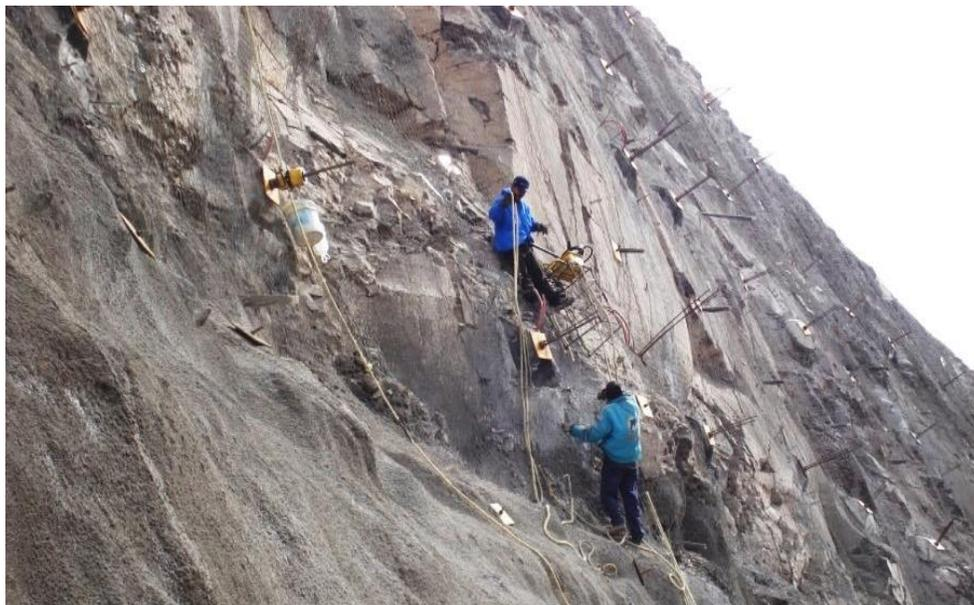
**Img. 155.** Trabajos de sujeción de *malla* triple torsión en pared de corte.
