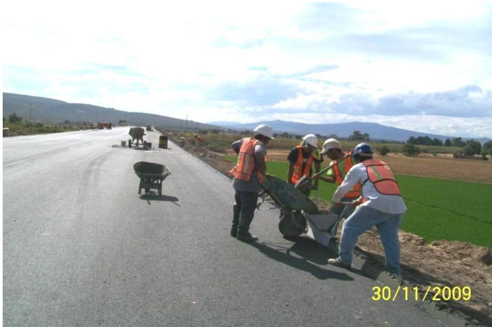
**Img 109.** Colado de *bordillo de concreto hidráulico*.
