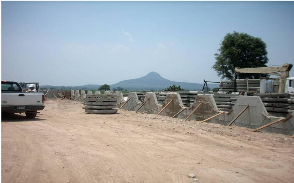
**Img 167.** Vista de la colocación de escamas en muro mecánicamente estabilizado de "tierra armada", km 0+883.00 Libramiento Norte de la Ciudad de México DGDC-SCT.
