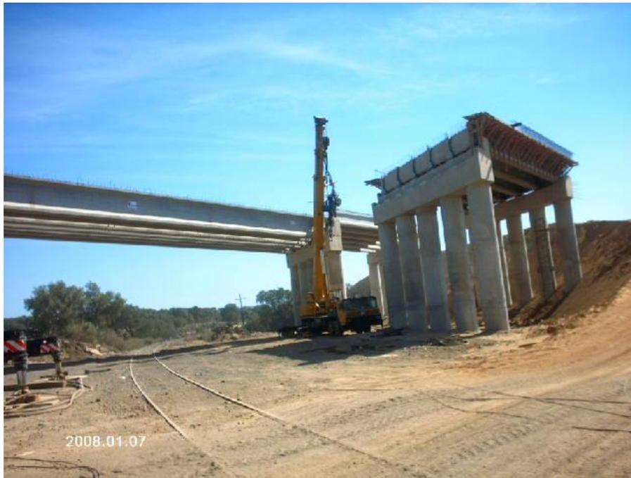
**Img 144.** Vista de la colocación de vigas prefabricadas en estructura, Libramiento Norte de la Ciudad de México, km 64+389, DGDC-SCT.
