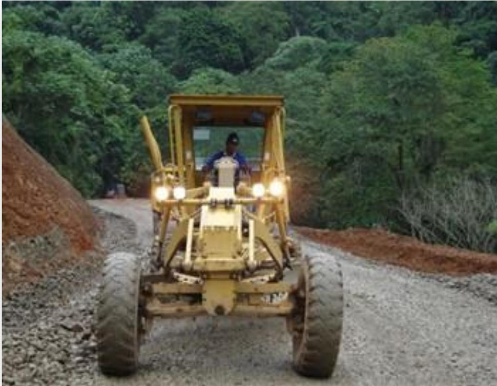
**Img 4.** Trabajos de conservación en terracería. Renivelación y tendido de material pétreo con motoconformadora, en un camino secundario sin revestimiento.
