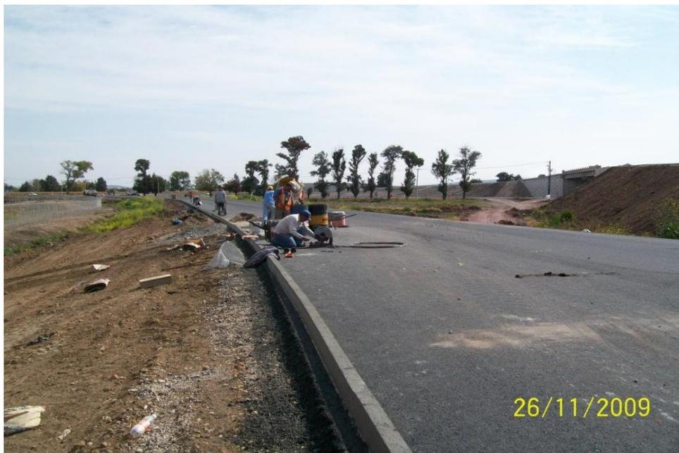
**Img 110.** Colado de *bordillo de concreto hidráulico*.
