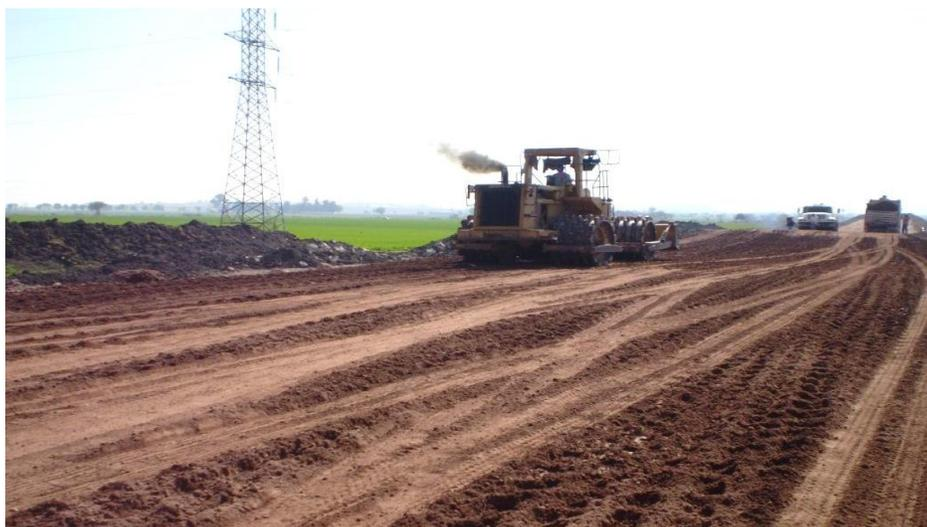
**Img 37.** Formación de terraplén en material “compactable”.
