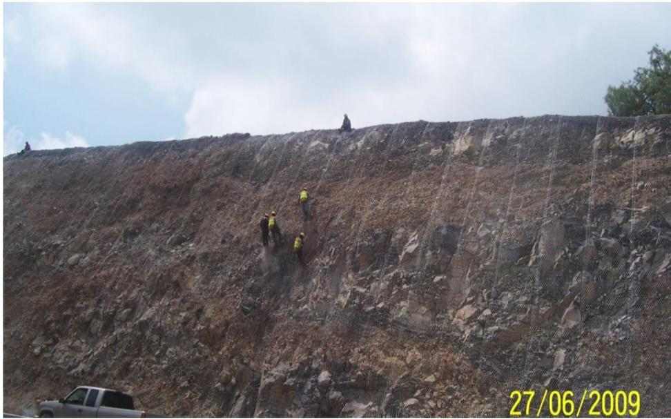
**Img 154.** Colocación de *malla* metálica triple torsión en pared de corte.
