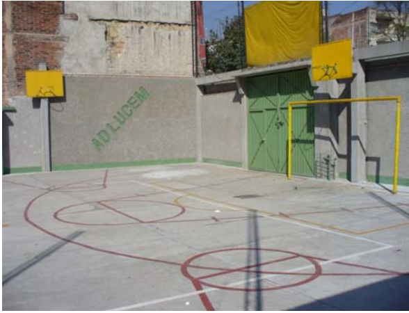
Foto 19. Patio trasero remodelado
