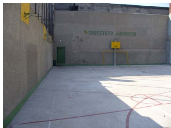
Foto 18. Patio trasero remodelado
