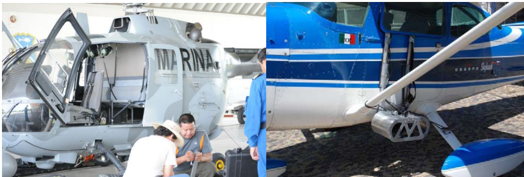
Figura 5. Instalación de las plataformas en helicópteros y aviones pequeños no especializados.
