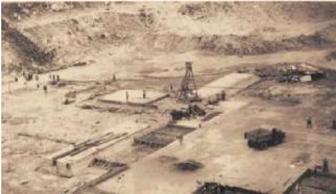
Figura 1.4. Construcción de la Presa Miguel Alemán
