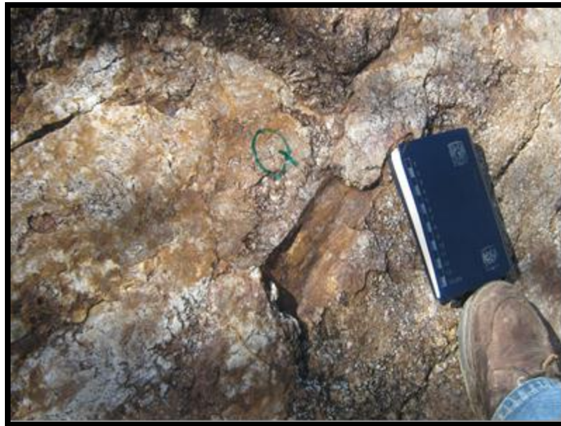
Figura 3.21. Falla lateral derecha, en un conglomerado, ubicado sobre el río Papala al SW de Tres Caminos.
