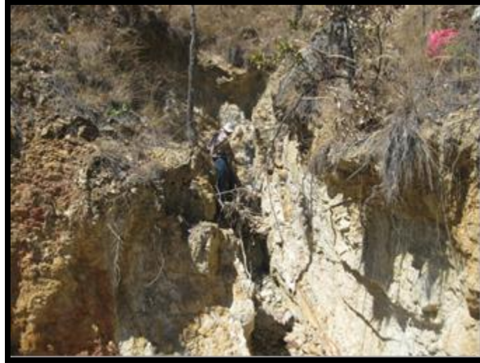
Figura 3.26. Localidad La Carretera, afectada por una falla lateral derecha.
