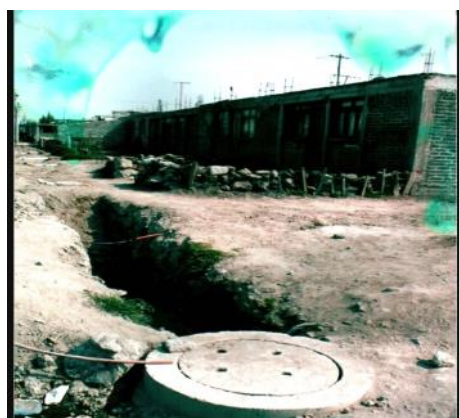
Imagen 6. Instalación de drenaje convencional.
