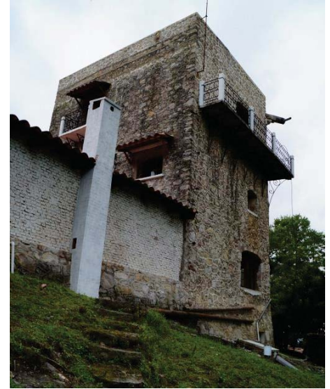
25. Vista del edificio A desde ladera poniente.
