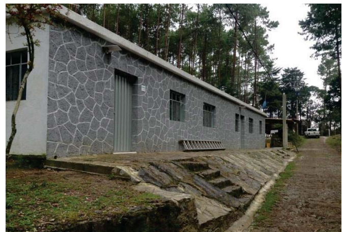
36. Vista desde el camino principal hacia el edificio E
