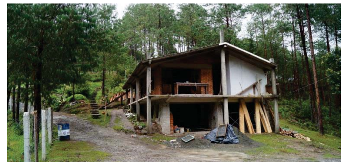
40. Vista del edificio F desde el acceso sur (chalet)
