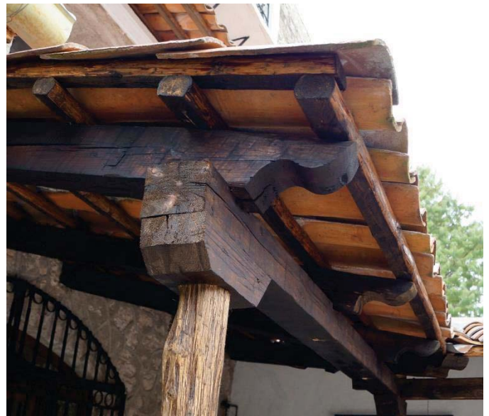
54. Vigas de madera utilizadas para sostener la cubierta de teja
