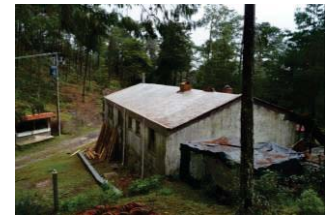
39. Vista desde ladera
