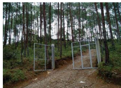
14. Vista del acceso norte y cerca perimetral
