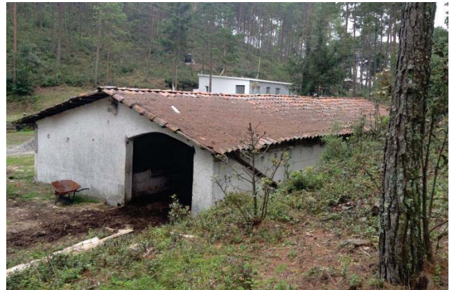
31. Vista del acceso en la fachada norte del edificio C
