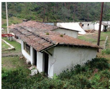
35. Vista desde el oriente del edificio D
