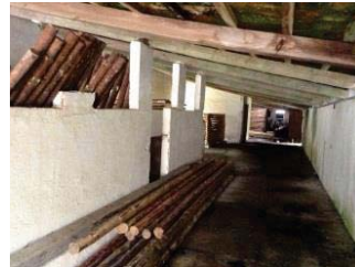
26. Vista interior edificio B
