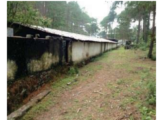
27. Vista de la fachada poniente
