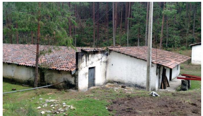
28. Vista del patio v volumen que contiene el pozo v el cuarto de maquinas
