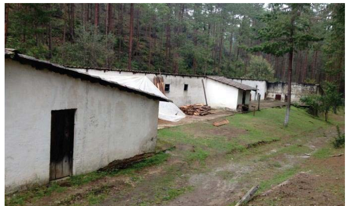
29. Vista desde el camino del edificio B
