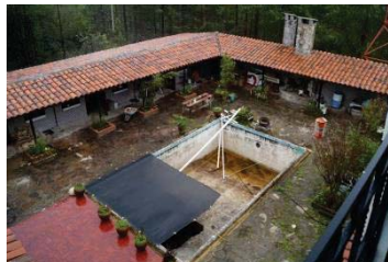
22. Vista del patio desde la torre
