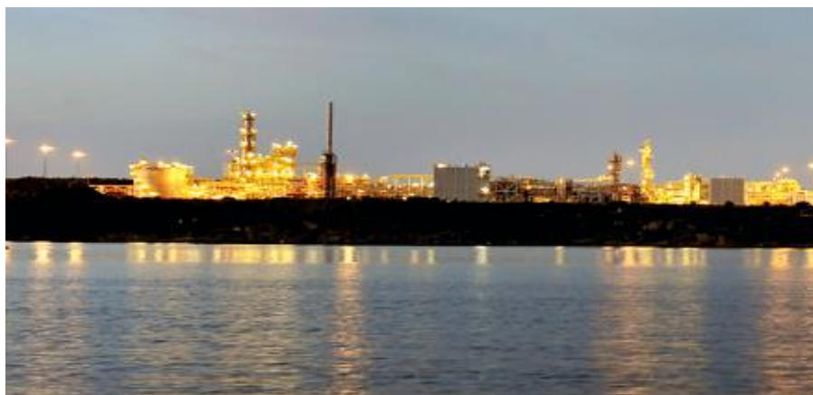
Figura 3.1 Foto de la planta procesadora de gas Kollsnes
