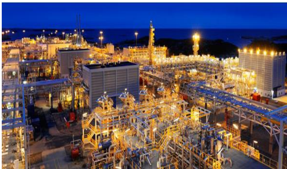
Figura 4.58 Planta procesadora de gas, Kollsnes
