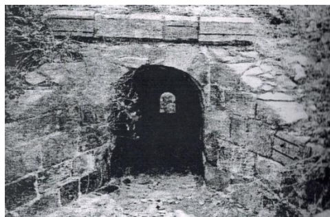
Fig. 1.6.- Alcantarilla de bóveda.
