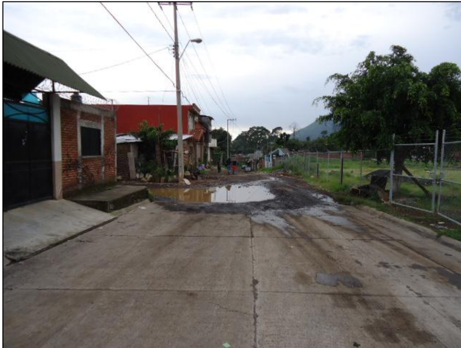
Fig. 3.16.- Final del tramo pavimentado.
