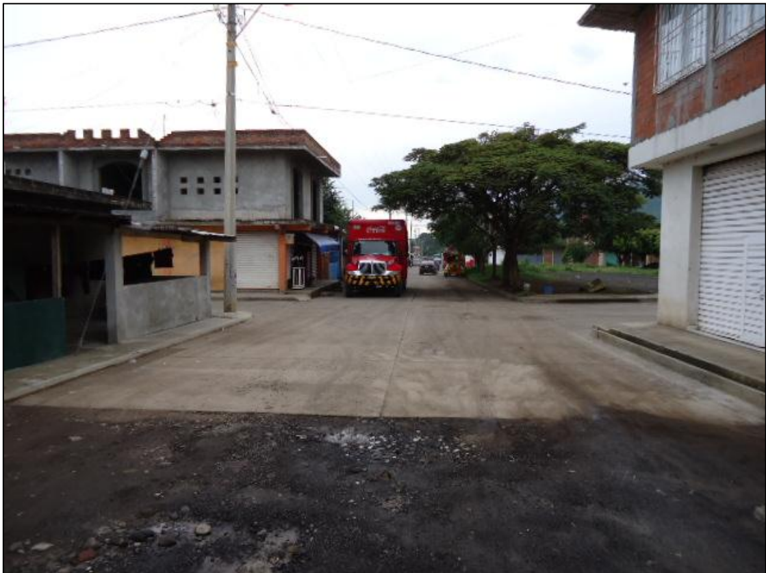
Fig. 3.14.- Inicio del tramo pavimentado.
