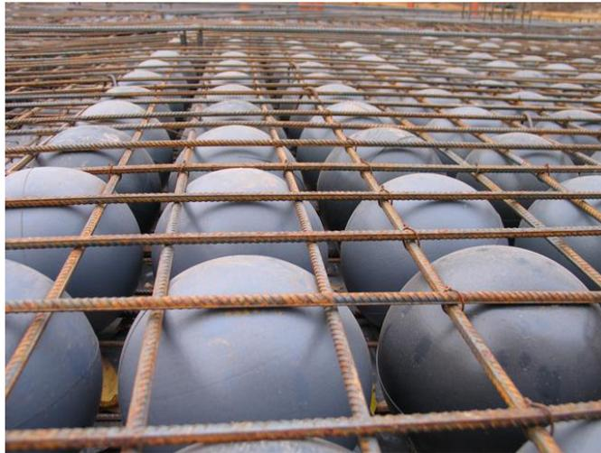
**Figura I-12** Para el aligeramiento de las losas se han usado diversos materiales y distintas formas. Losa aligerada con esferas.
