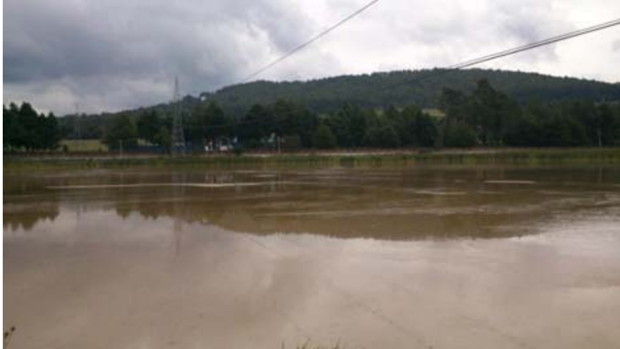
Figura 12. Sitio de disposición de lodos provenientes de la coagulación con sulfato de aluminio en la planta Los Berros
