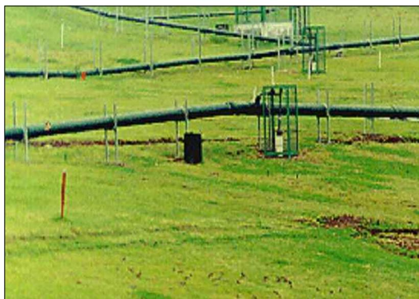
FOTOGRAFIA DE POZOS DE EXTRACCION (QUEMADORES DE BIOGAS= PRADPS DE LA MONTAÑA , STA.FE. CUAJIMALPA
