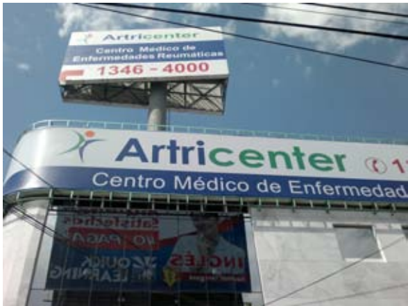
Instalaciones Artricenter Zaragoza
