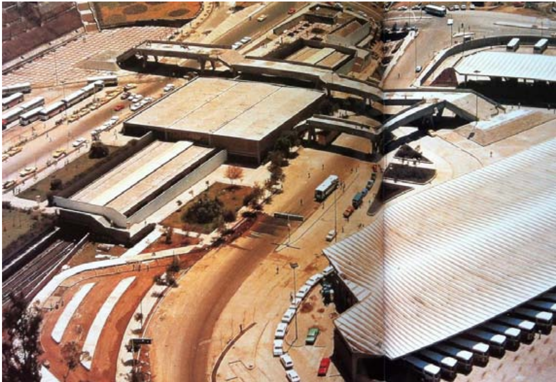
Imagen 4. Estación terminal Observatorio, 1972 (a la izquierda el paradero de autobuses foráneos, al centro la estación del metro, a la derecha la terminal de autobuses poniente)
