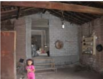
Figura 52: Ampliación de la vivienda tradicional. Los muros originales son de adobe y, los nuevos, de ladrillo y cemento. En cada uno de estos espacios habita una familia (foto: Martínez, 2012).
