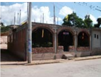
Figura 53: Vivienda "moderna" de Santiago Cacaloxtepic; construida con ladrillo, cemento, varillas. Consta de varias habitaciones interiores (foto: Martínez, 2012).
