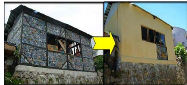
Figura 36. - Construcción a partir de botellas de plástico (casa en Guatemala)
