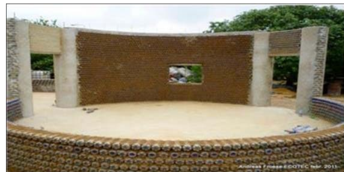
Figura 39 . - Casa construida con botellas PET en Nigeria Fuente: http://generatuenergia.com/2011/11/29/Construcción-sostenible-reciclando-botellas-pet-nigeria-africa
