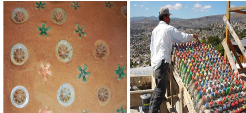
Figura 41. - Acabado estético con las botellas vistas y construcción de bóveda en Tegucigalpa, Honduras en 2005 Fuente: http://ecococos.blogspot.mx/2012/03/sistema-constructivo-con-botellas-de.html
