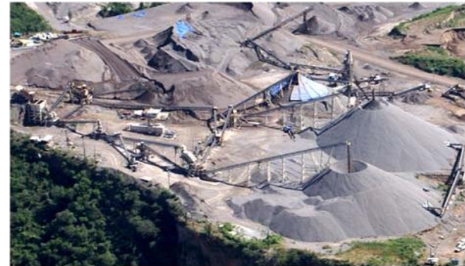
Figura 68. - Planta de trituración Presa PH La Yesca (Cortesía CEMEX Concretos http://www.acimexico-snem.org/online/destacados/boletin-tecnico-
