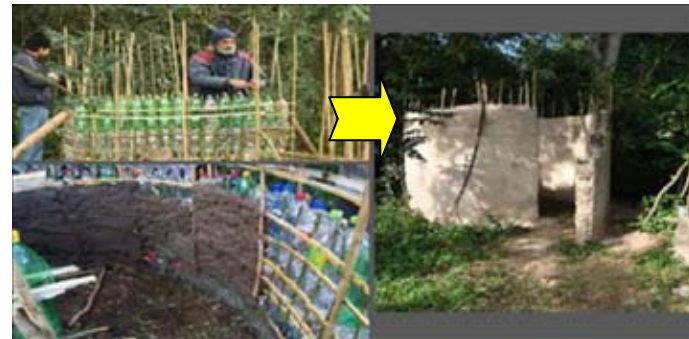
Figura 38. - Construcción con madera, PET y mortero Fuente: García H. E. (7 octubre de 2011).
