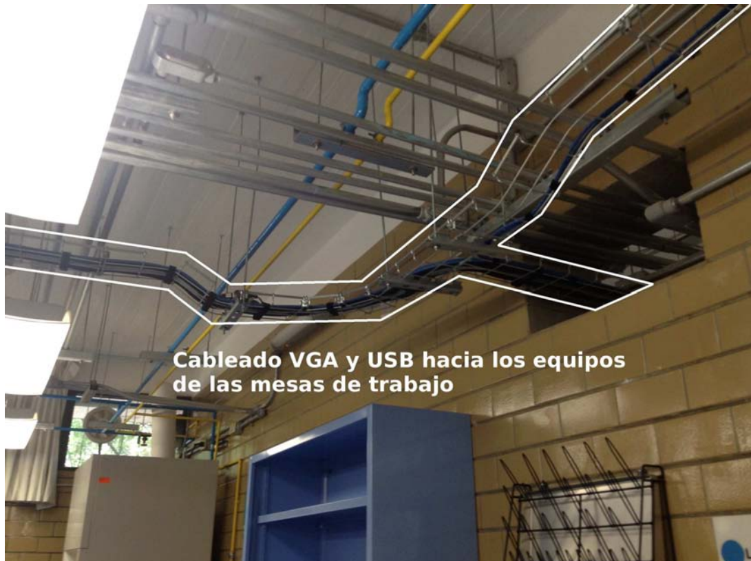
Figura 4.4: Cableado VGA y USB hacia los equipos de las mesas de trabajo.
