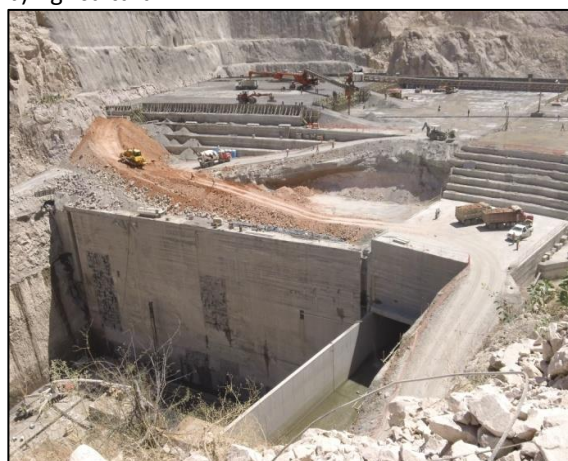
d) Construcción de la presa El Zapotillo
