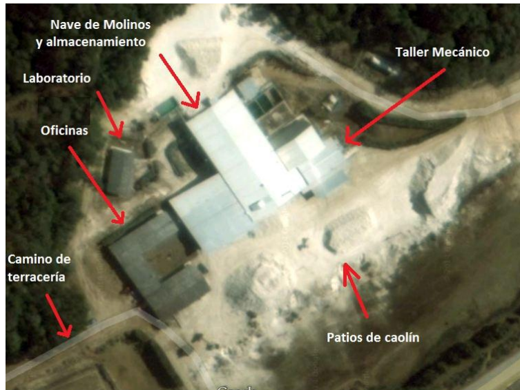
Ilustración 21. Infraestructura de la planta de Huayacocotla (Google Maps, 2014)
