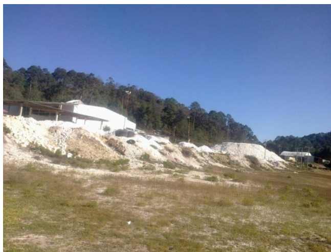
Ilustración 13. Fachada de la planta Unicaolín de Huayacocotla
