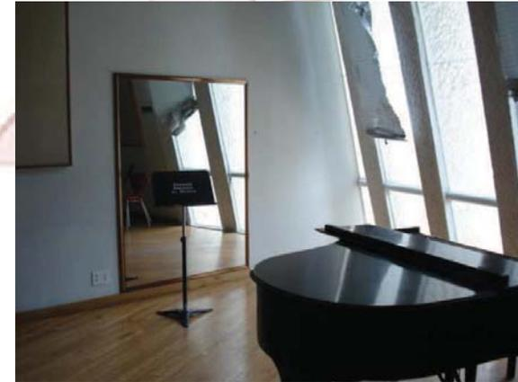
Aquí se puede apreciar que el muro de esta aula está inclinado hacia el interior del aula. Esto es, porque no se puede evitar que el sonido “rebote”, pero si se puede evitar que el punto de incidencia del sonido sea el mismo evitando la reverberación y confundir al ejecutante o al público. Esto aunado al uso de placas que adsorban ese rebote, se conseguirá una apreciación mas efectiva del sonido, lo cual es sumamente importante en la practica de conjuntos vocales o ensambles de percusiones.
